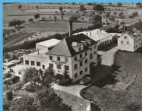
Drulingen Maison des Services (ancienne centrale beurrière)
